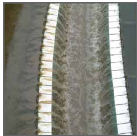
Efekty wadliwej pracy osadników - „chmury” osadu i wypłukiwanie zagęszczonego osadu.
