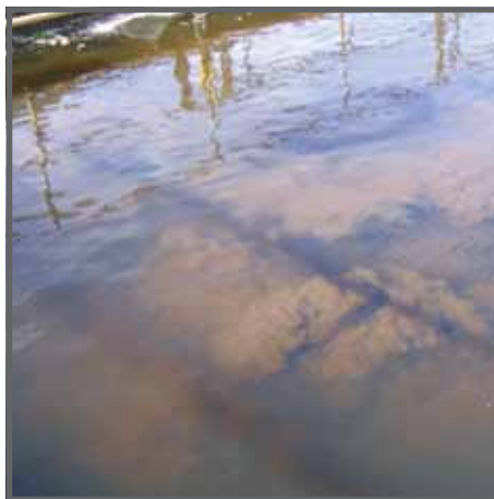
Efekty wadliwej pracy osadników - „chmury” osadu i wypłukiwanie zagęszczonego osadu.
