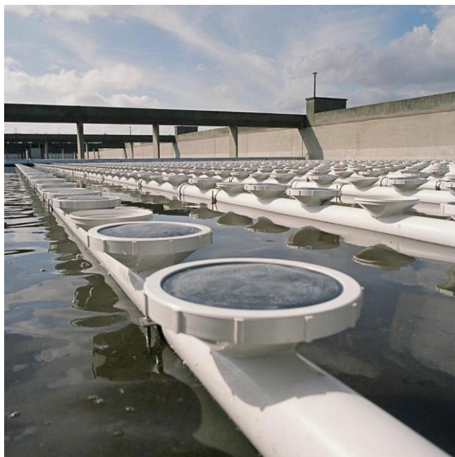
System napowietrzania ścieków Sanitaire Silver
