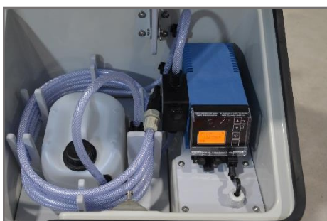
Pompka dozująca w zakresie wydajności od 1,4 do 11,2 l/h.
